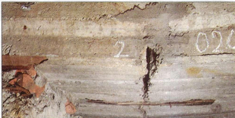
Продольная трещина по нижней поверхности ростверка шириной раскрытия до 5 мм.
