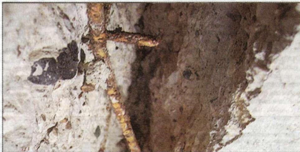
Продольная сквозная трещина шириной раскрытия до 80 мм с максимальным раскрытием на нижней грани ростверка.
